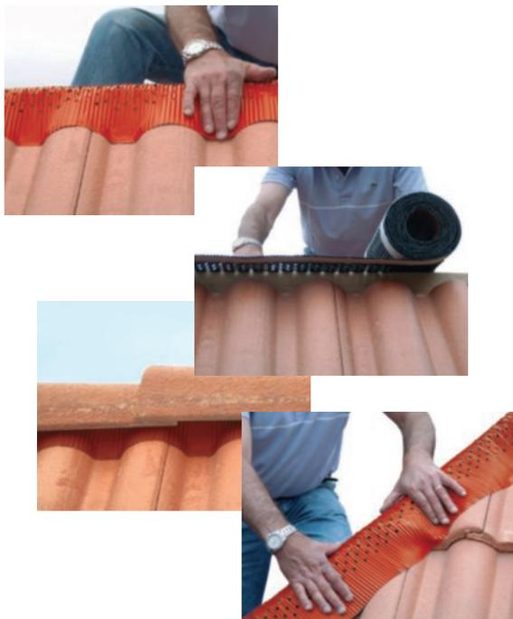
Cuando se quiere hacer una cubierta de tejado con ventilación, las normas exigen que ésta debe ser segura y permanente. Con DUROFLEX ventilación instalado en la cumbre o en la limatesa se garantiza la ventilación y se evita que la humedad cause daños en la cubierta.
